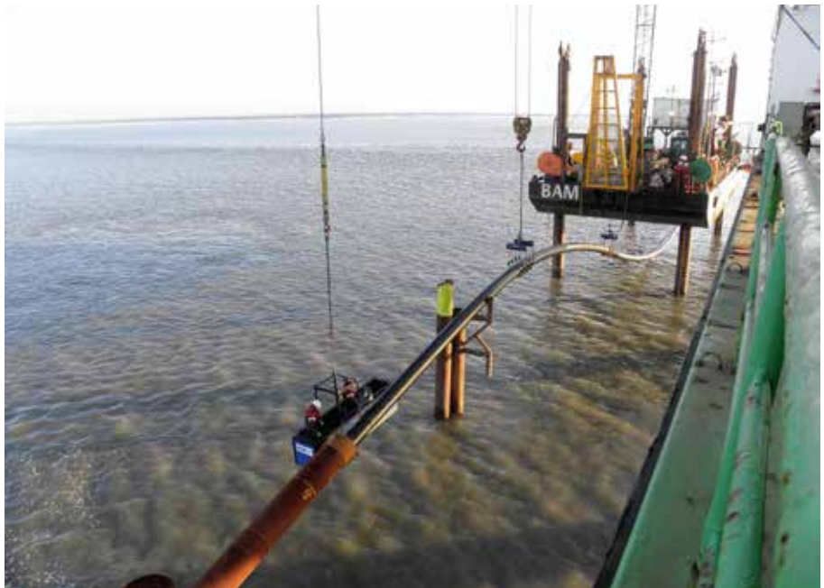
Het intrekken van de mantelbuis is een spectaculair gezicht.
