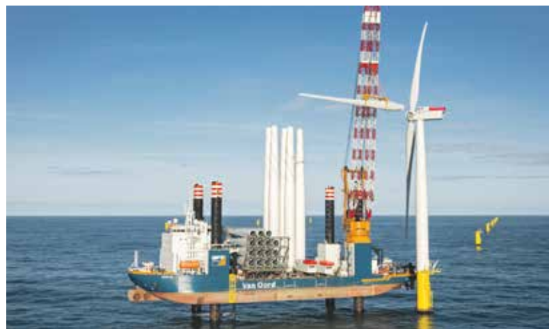
Installatie door de Aeolus van de eerste windturbine in het Gemini-park. (Foto Van Oord)
